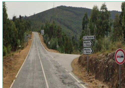
Aproveitamento da plataforma + alargamentos, perto do final da obra
