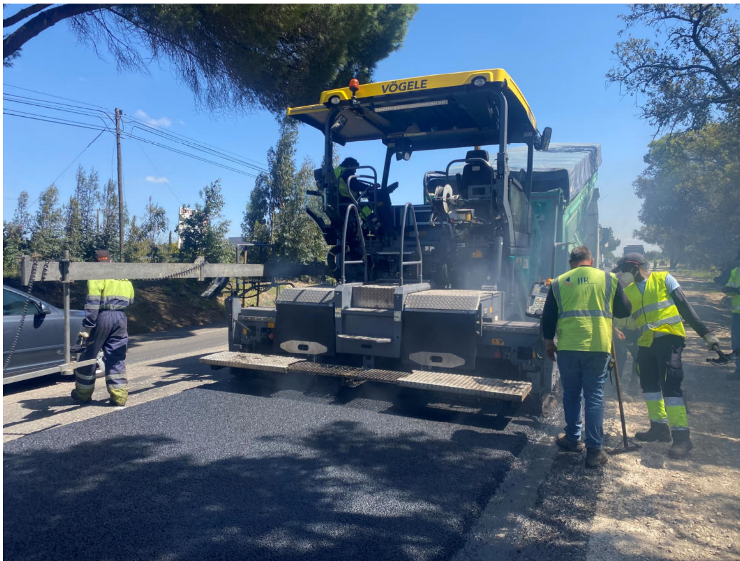
Operação em Pavimentação de Camadas Betuminosas com Borracha Reagida e Ativada (RAR)
