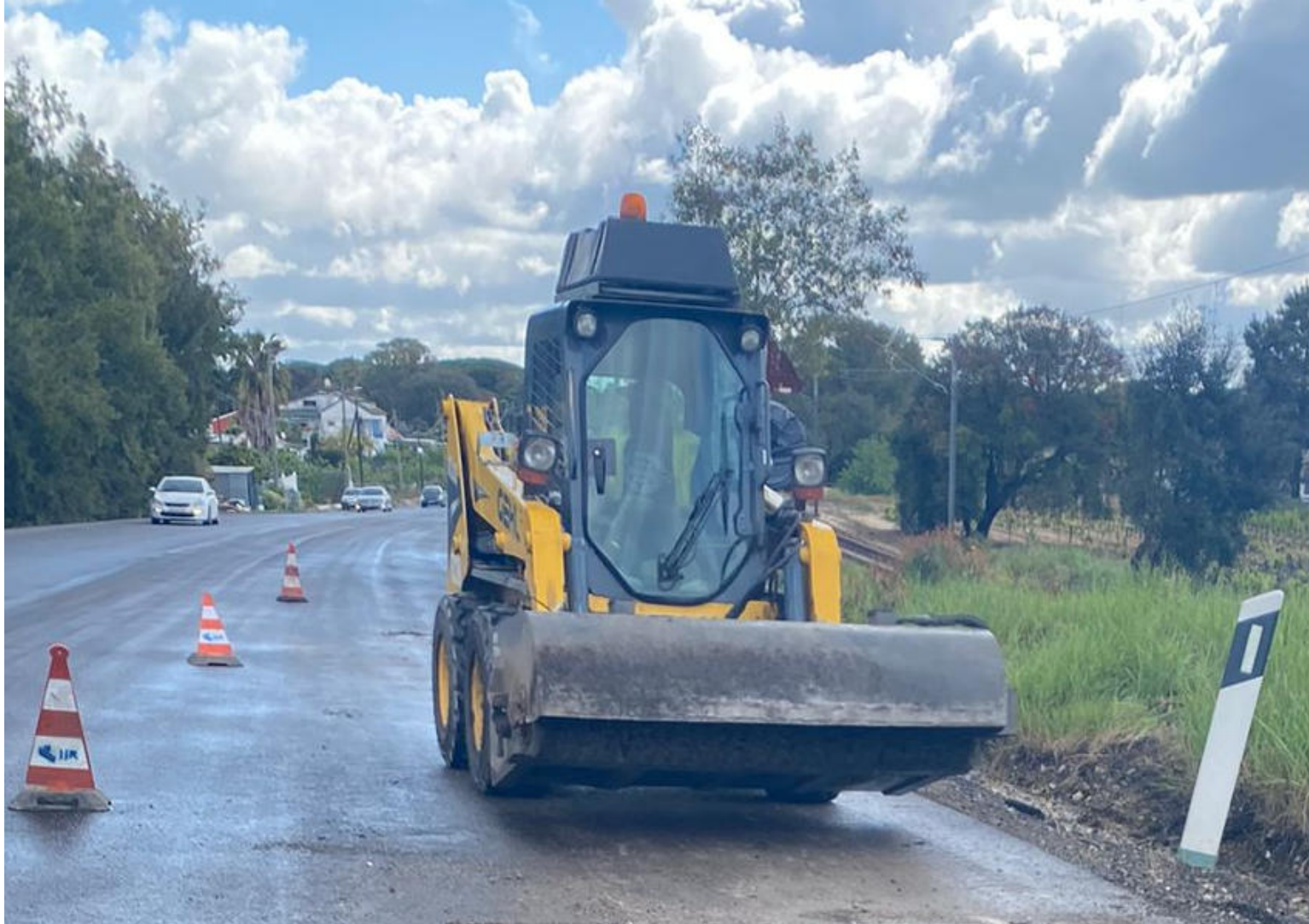
Trabalho em Pavimentação Betuminosas Máquina Reagida e Ativada (RAR)
