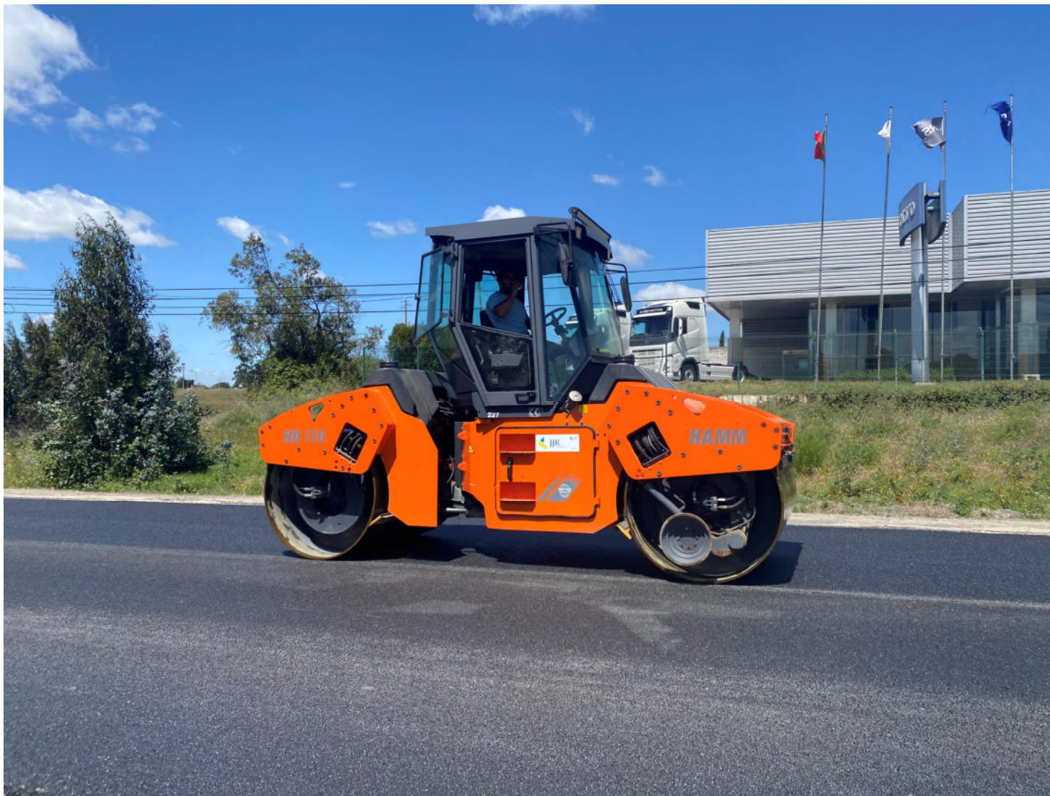
Operação em Pavimentação de Camadas Betuminosas com Borracha Reagida e Ativada (RAR)
