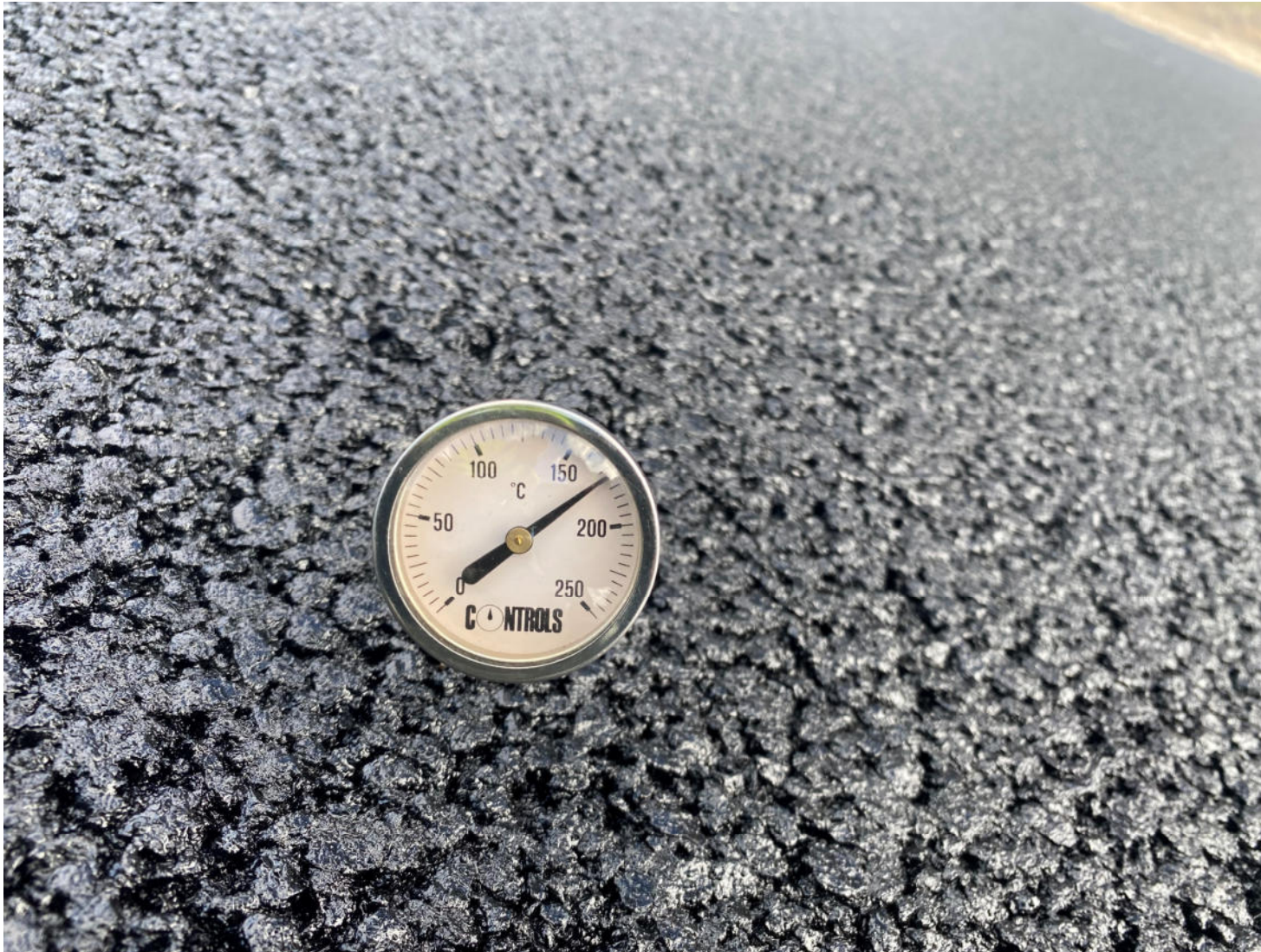
Medição em Pavimentação Misturas Betuminosas Borracha Reagida e Ativada (RAR)
