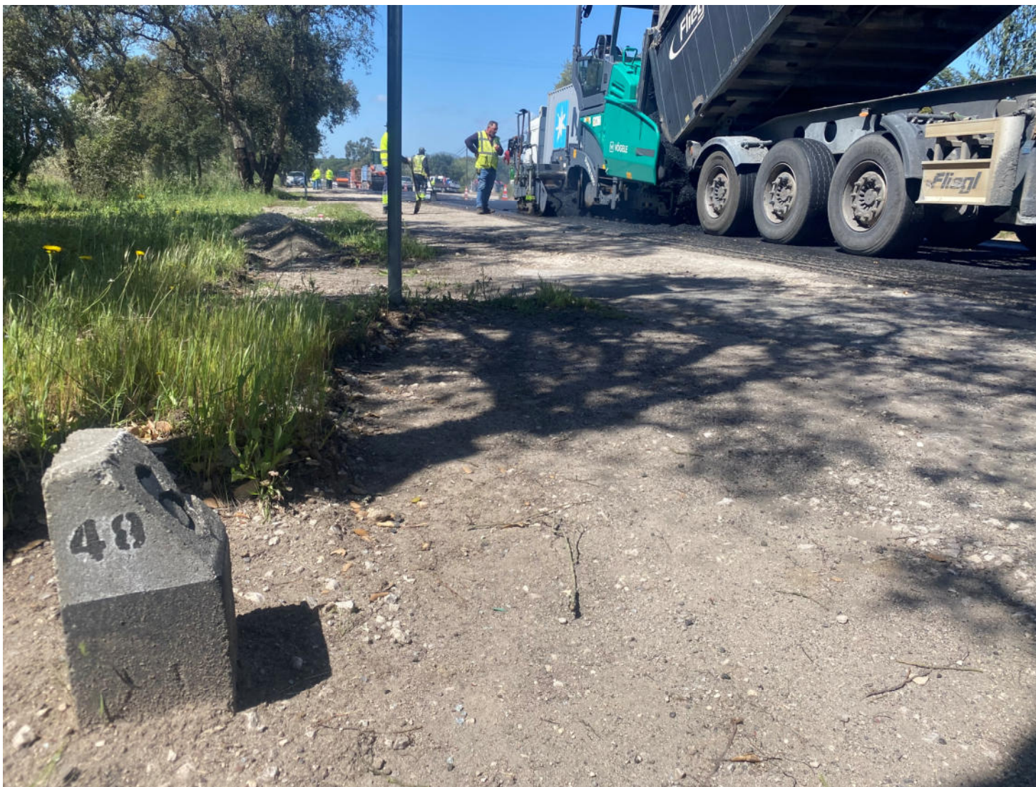
Aplicação em Pavimentação de Misturas Betuminosas com Borracha Reagida e Ativada (RAR)
